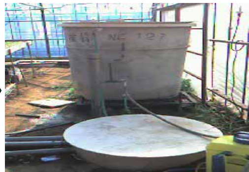
養液水槽タンク
